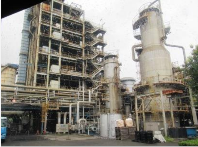
▲ガス化プラント
